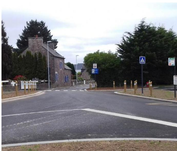
Nous avons opté pour un partage de la rue entre cycles et automobiles par la création d'un « Chaucidou » (contraction de "chaussée pour les circulations douces"), chaussée à voie banalisée. Il s'agit d'un rétrécissement de la voie routière et la création d'une zone cyclable par des pointillés donnant priorité aux vélos.
